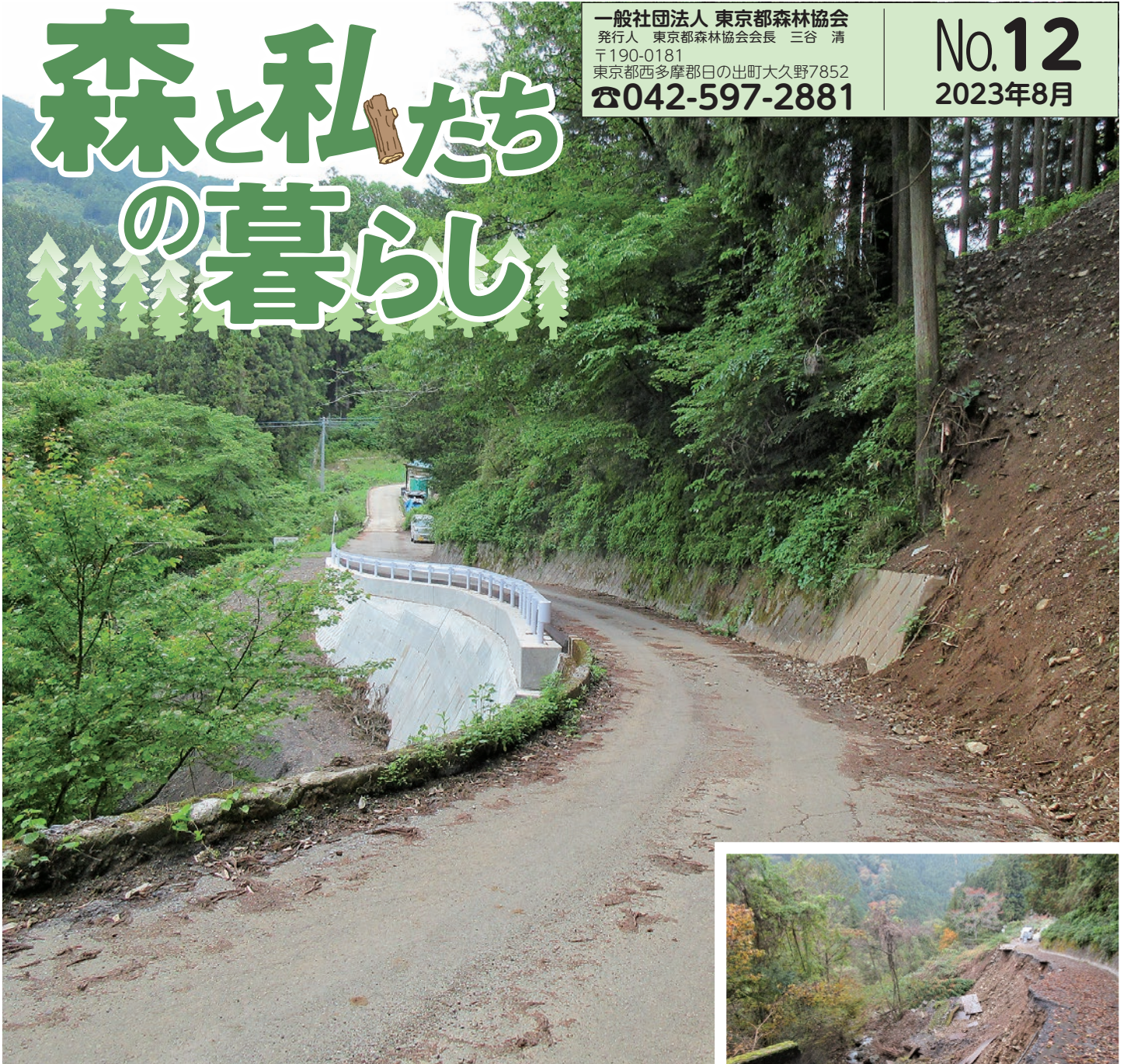
復旧した林道
