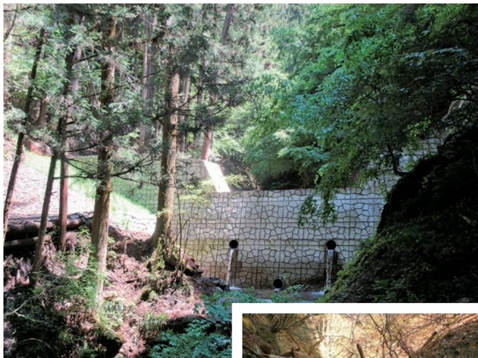
復旧した治山工事現場
