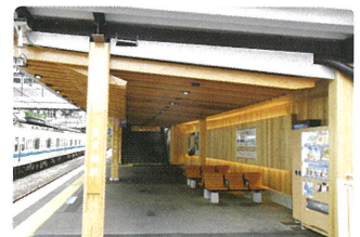
建築物等 (小田急線参宮橋の駅舎改築)
